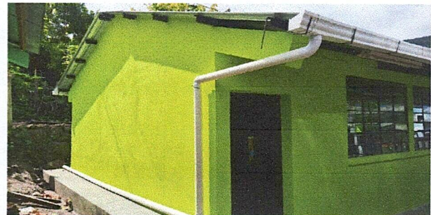
Foto 4: Reparación de repello y cernido de paredes
