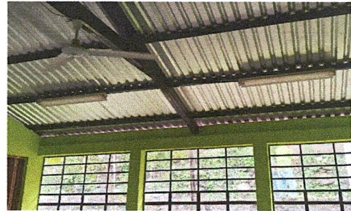
Foto 2: Cubierta de láminas
