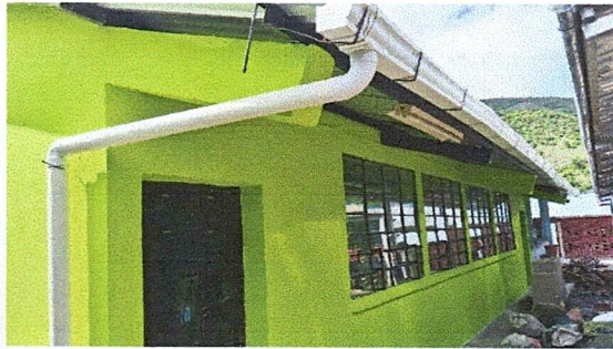
Foto 1: Edificio Escolar a remozar
